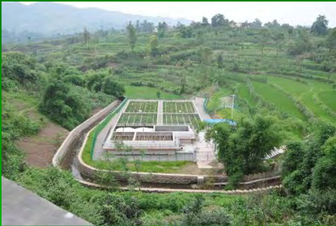
白羊污水处理厂建成后全景
