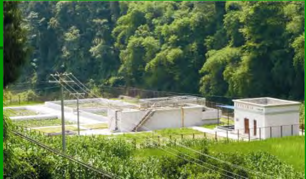
马灌污水处理厂建成后全景
