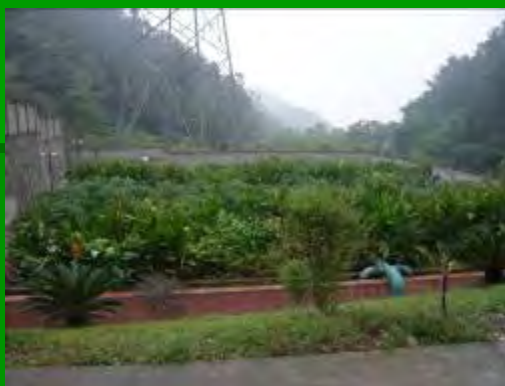
沙坪坝区 2500m 3 /d好氧+人工湿地工艺
