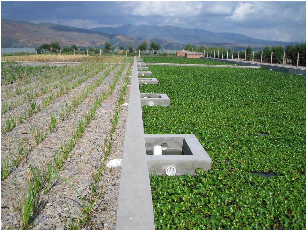
刚施工完毕的湿地系统
