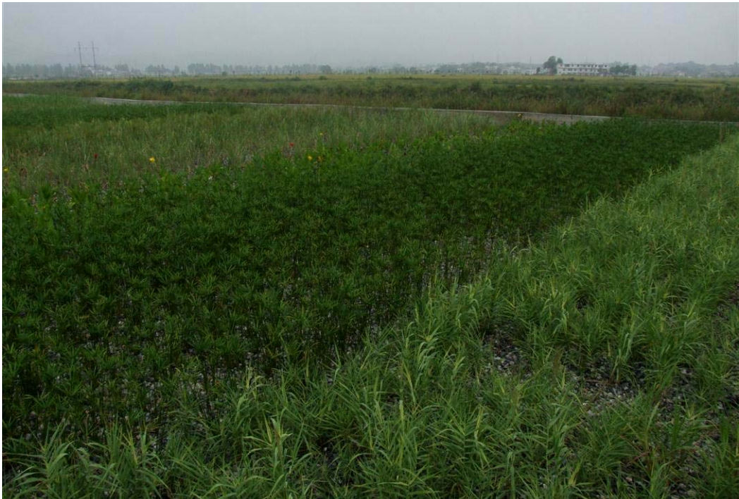
正常运行期的南坑人工湿地（污水在填料以下运行）
