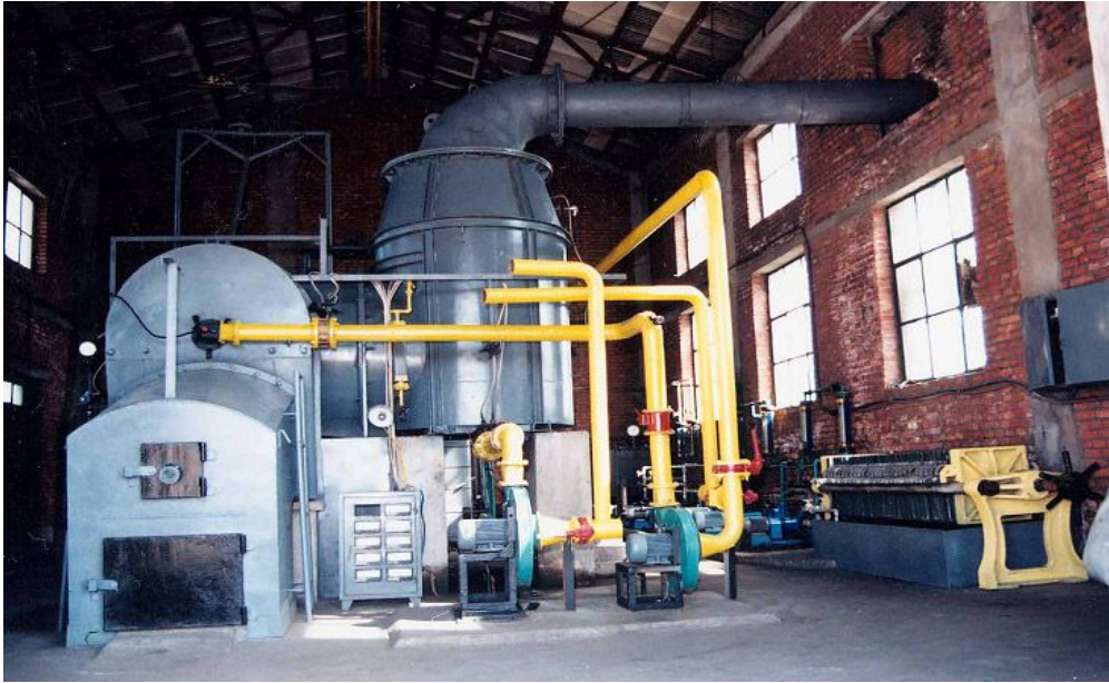
图 6.5 沈阳危险废物焚烧示范工程
