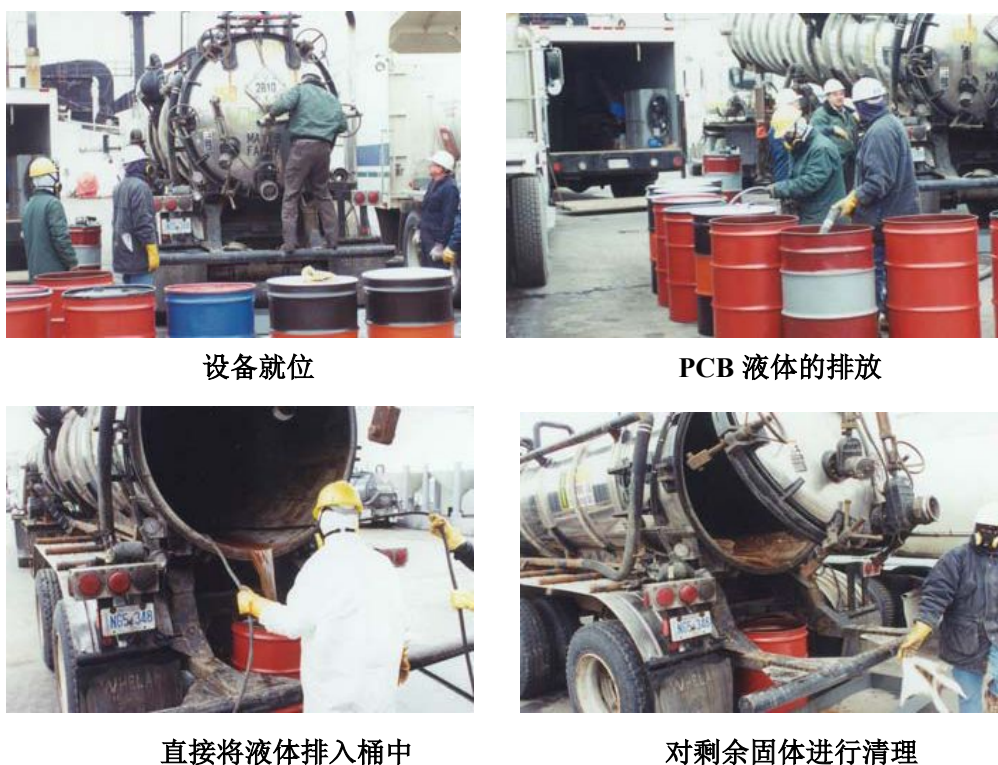
图 6.1 设备中 PCBs 液体的收集方法
