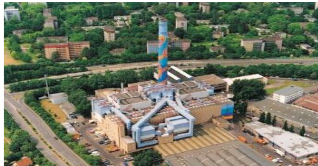
德国法兰克福生活垃圾焚烧厂
