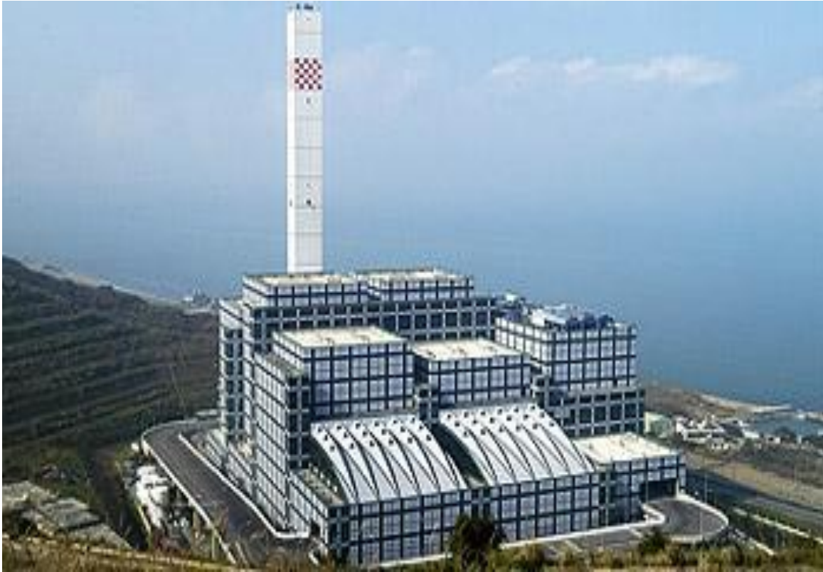
台北县八里垃圾焚烧厂/贝律铭
