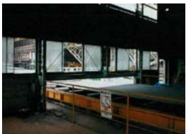
防锈涂装作业
