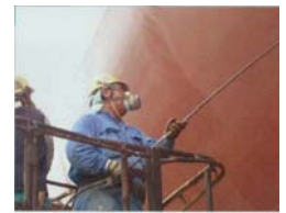
室外涂装作业 (船坞内)
