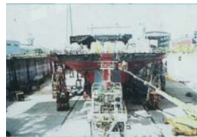
室外涂装作业 (船坞内)
