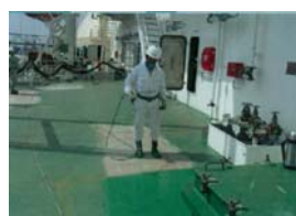
最后的涂装作业 (岸壁)
