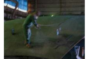
室内涂装作业
