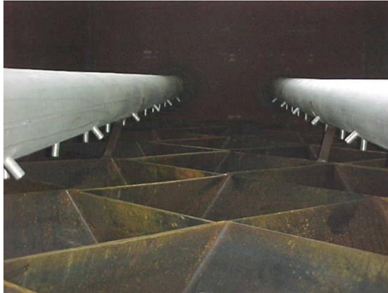
图6.6 喷嘴和静态混合器
