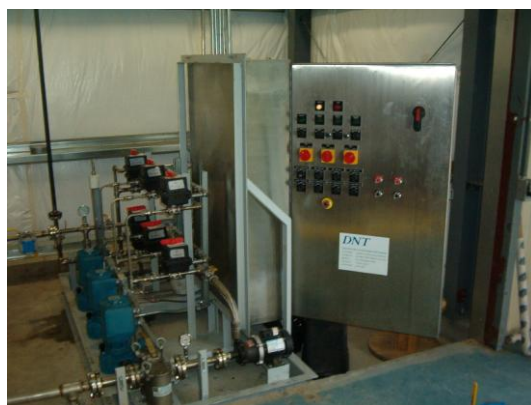
图 5.9 还原药剂的输送和控制装置
