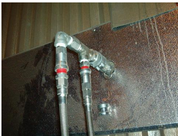
图 5.10 墙式喷嘴现场应用图
