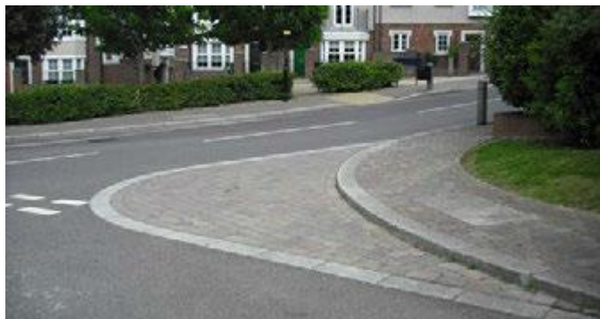
图7.10 大缘石半径改造为小缘石半径
