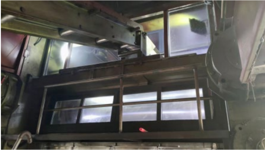
图 2.3-10 工段产污工位精细化围闭收集
