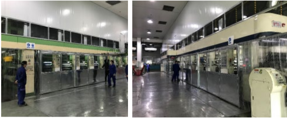
图 3.5-1 印刷生产线密闭情况
