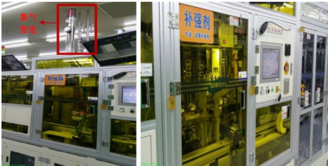
图 2.1-3 补强剂涂敷（密闭空间作业）和 VOCs 收集（密闭的集气管道）
