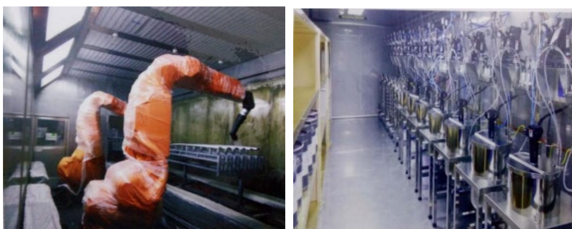
图 2.3-4 密闭生产车间和自动喷漆设备
