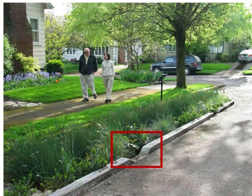
图 16.1-5 路面雨水进入路边绿地（植草沟）做法案例
