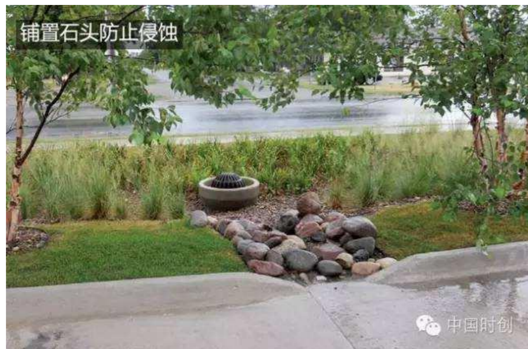
图 16.1-7 路面雨水进入路边绿地（植草沟）做法案例
