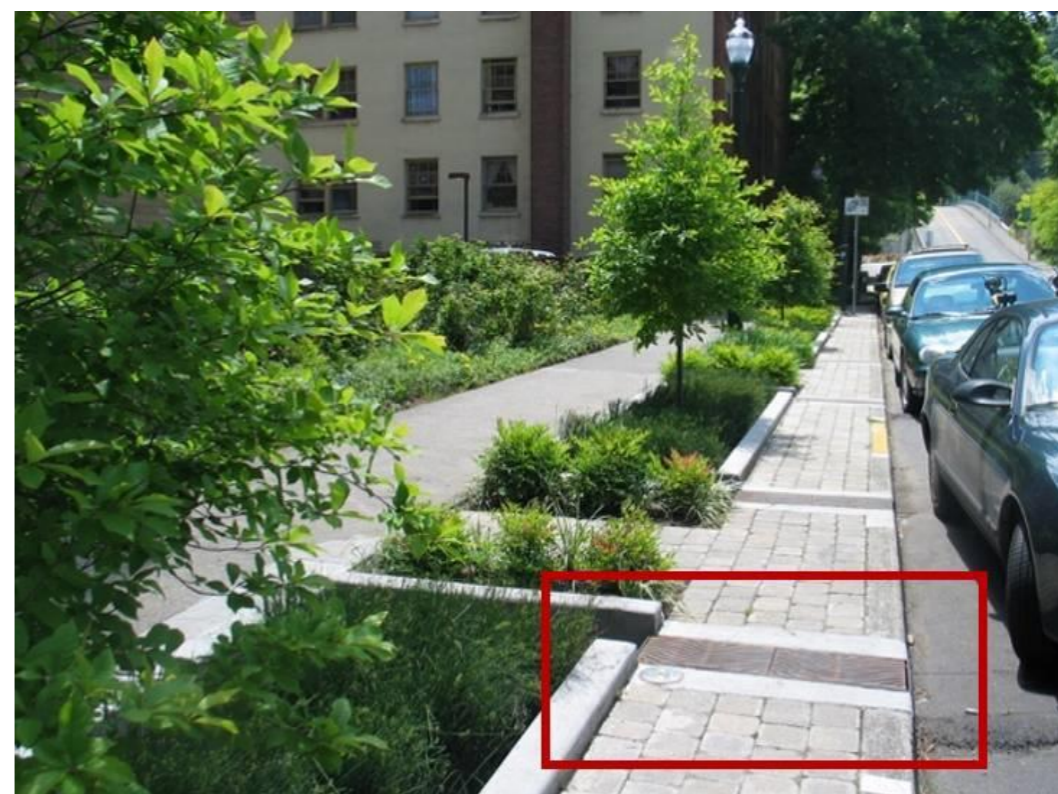
图 16.1-4 路面雨水进入路边绿地（植草沟）做法案例
