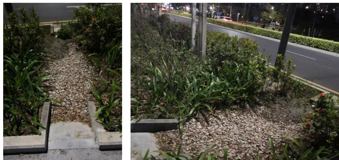
图 16.1-6 路面雨水进入路边绿地（植草沟）做法案例
