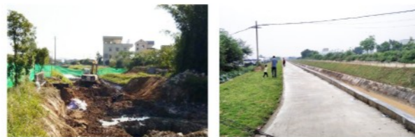
联安村段施工中 联安村段施工后
