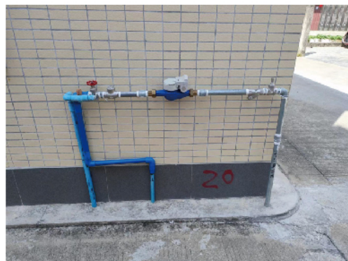
儒林村农村供水改造
