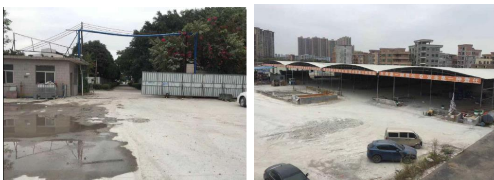
图 3.6-26 广州市浩海环保建材有限公司选址现场实拍图
