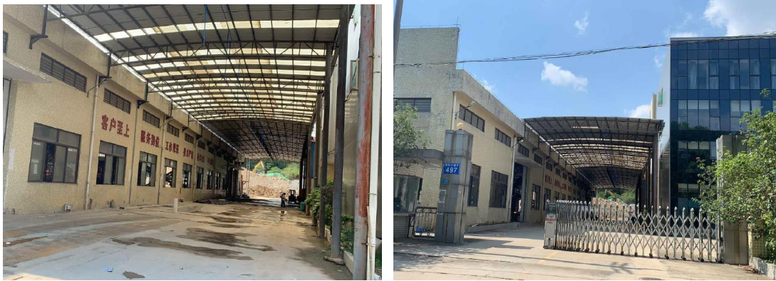
图 3.6-38 广州市利锦建筑废料处置有限公司选址实拍图
