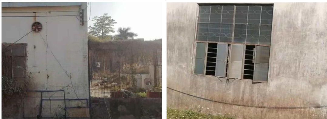
图 3.6-30 广州潮榕水泥制品有限公司选址现状实拍图
