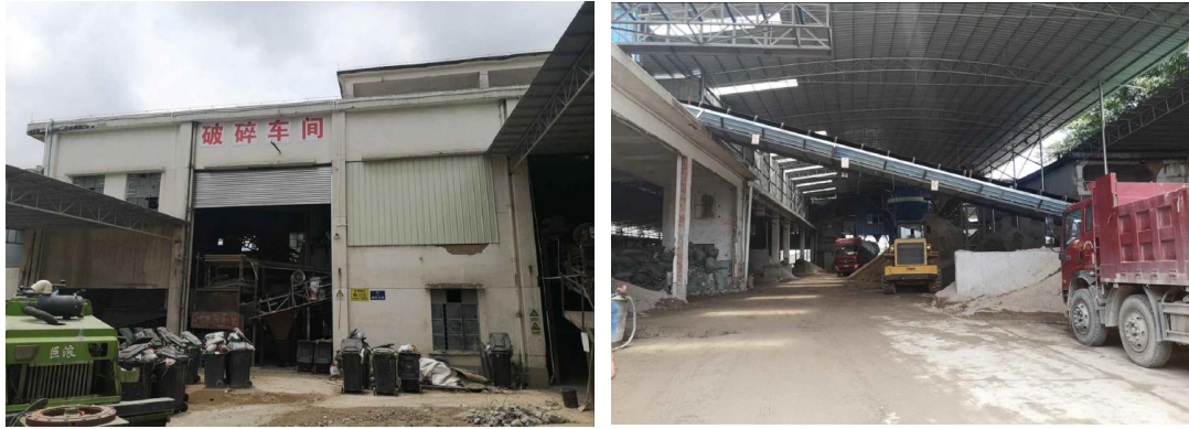
图 3.6-18 花东镇天和村建筑废弃物消纳场选址实拍图
