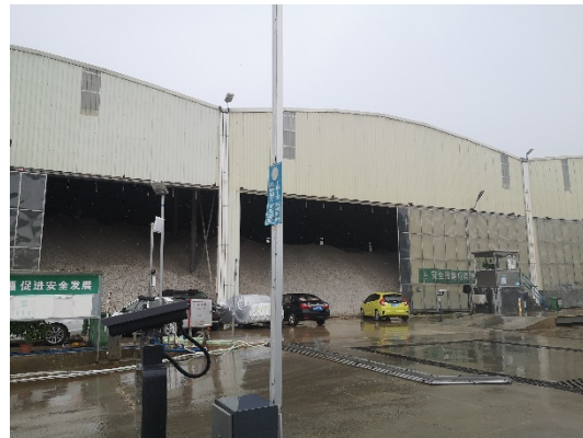
图 8-6 综合利用厂成品堆放区
