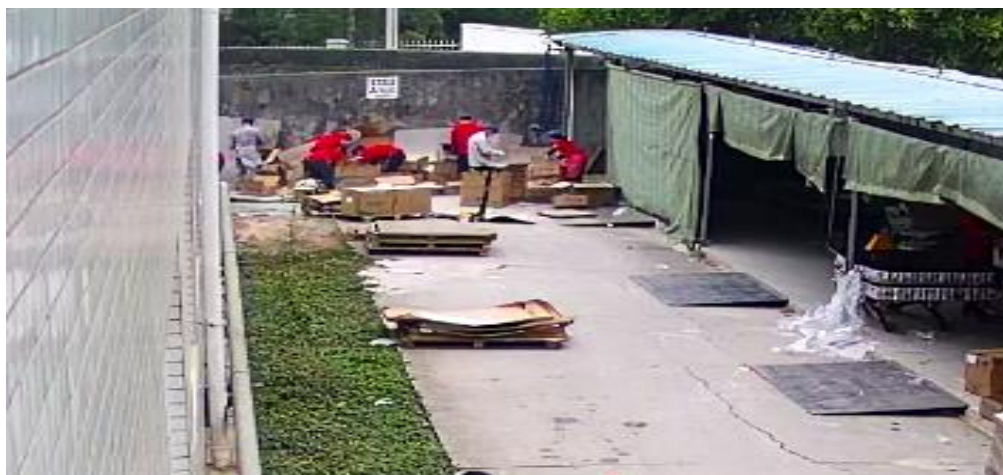
图4为戳罐作业现场情况（时间为12月16日17时4分）
