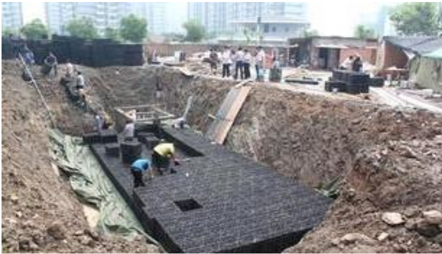
图 5.8-2 塑料雨水净化调蓄池参考图
