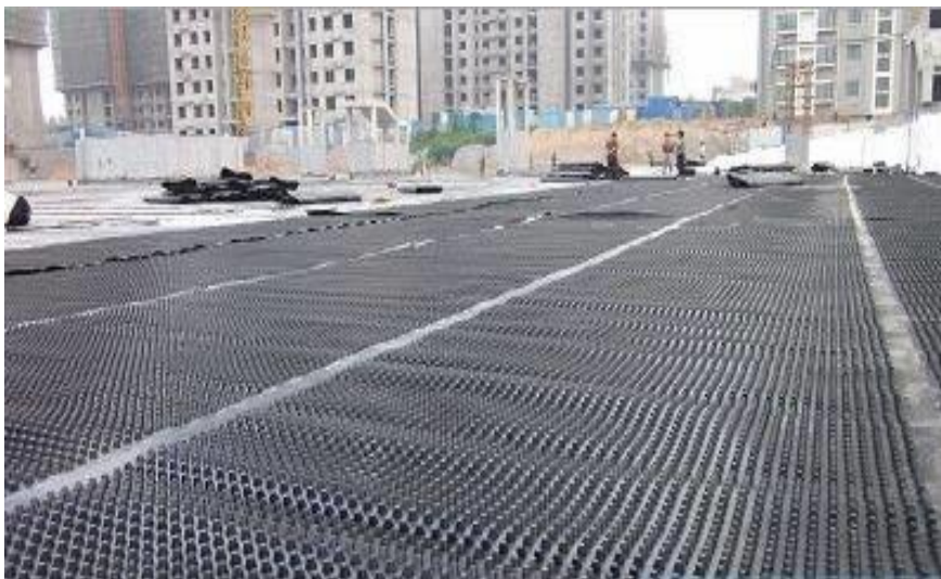
图 5.10-4 排水蜂房施工参考图
