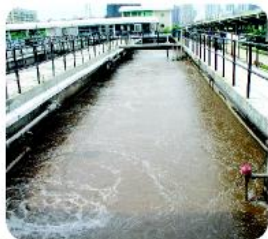
● 猎德污水处理
