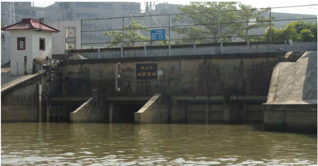
图 3-4 城西泵站排水口
