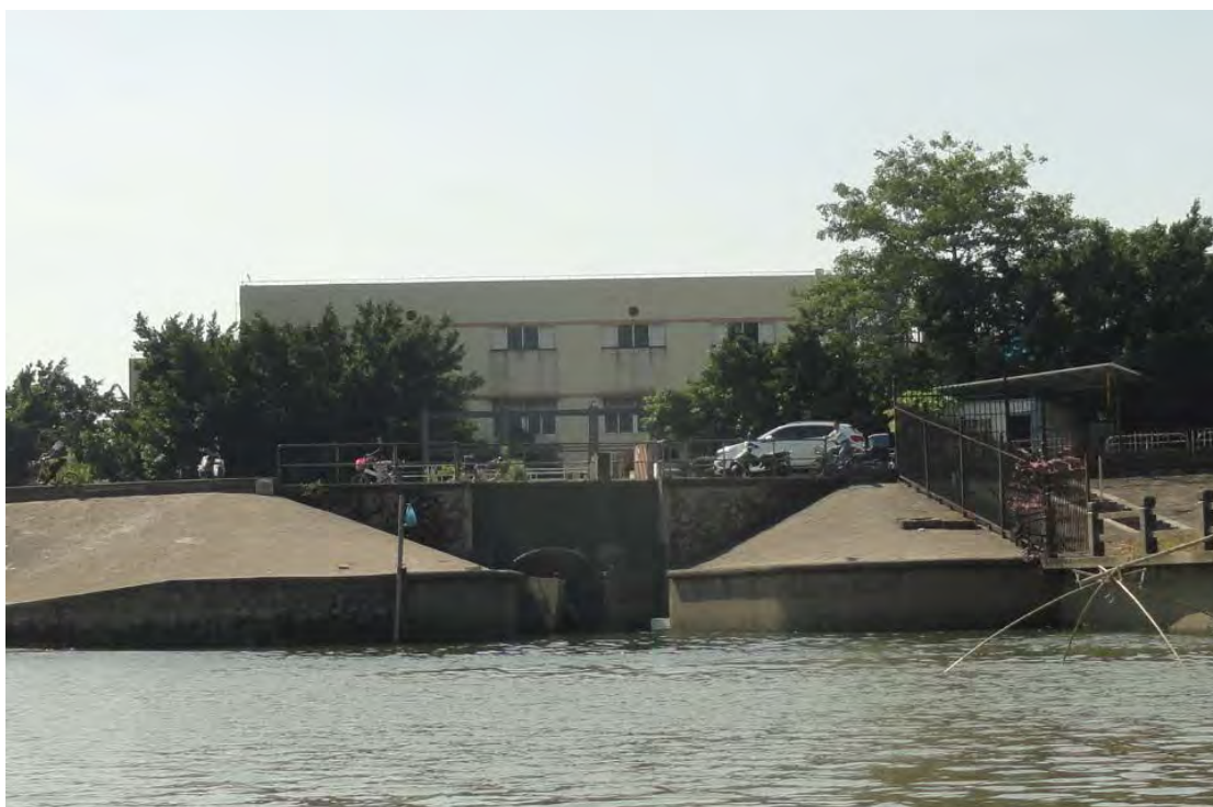
图 3-2 城北污水处理厂排水口
