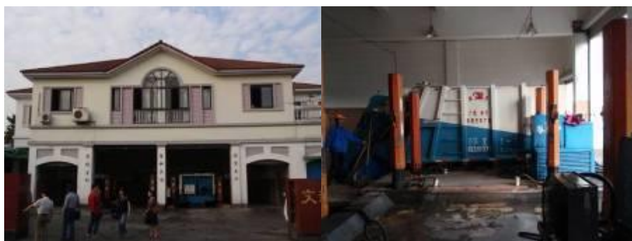
图 0-31 杭州市垃圾转运站
