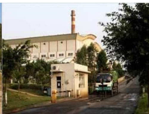
图 0-27 深圳龙岗垃圾焚烧发电厂
