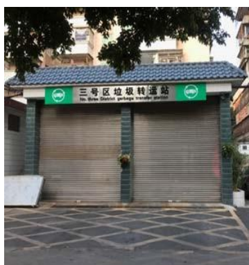
三号区垃圾中转站
