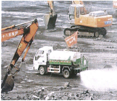
作业区域洒水
