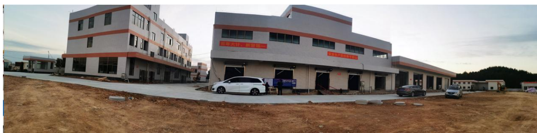
图 3-2 恩平现代化生猪屠宰加工物流中心建设现状
