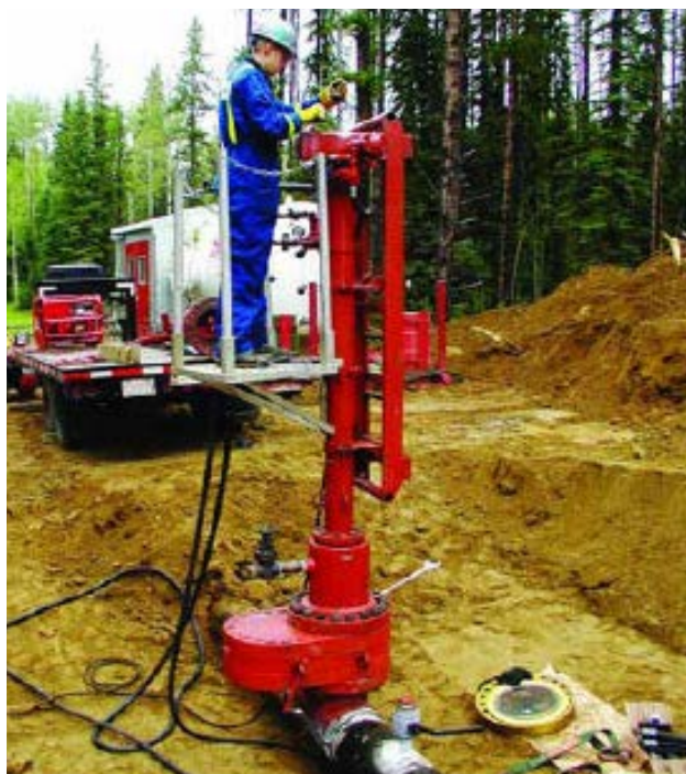
图4: 管道封堵施工示例 2
