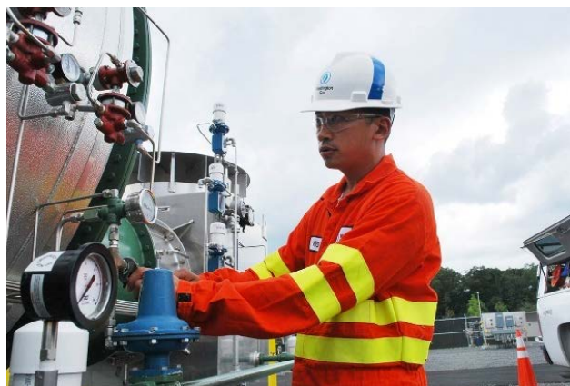
图 1: 正在进行初步维修 1
