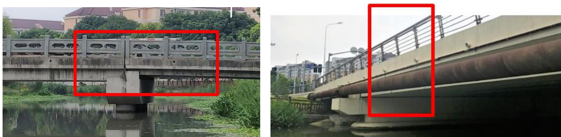
图9 桥梁、道路、堤坝两侧的泄水口
