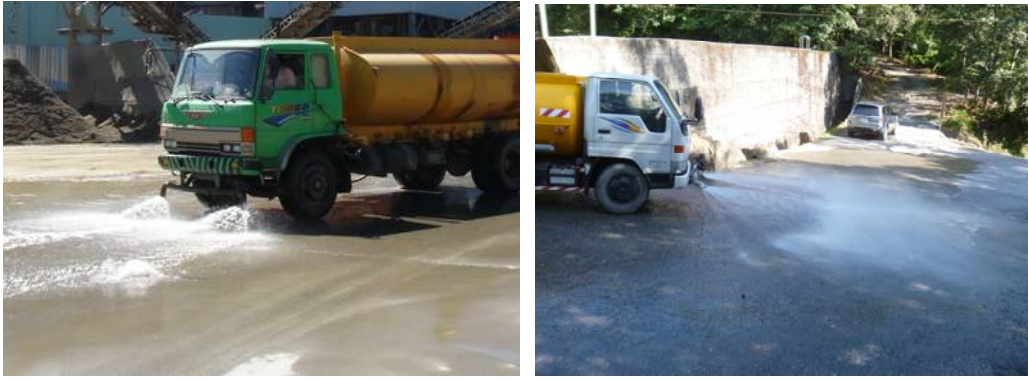
圖3-23 洗街車作業實照
