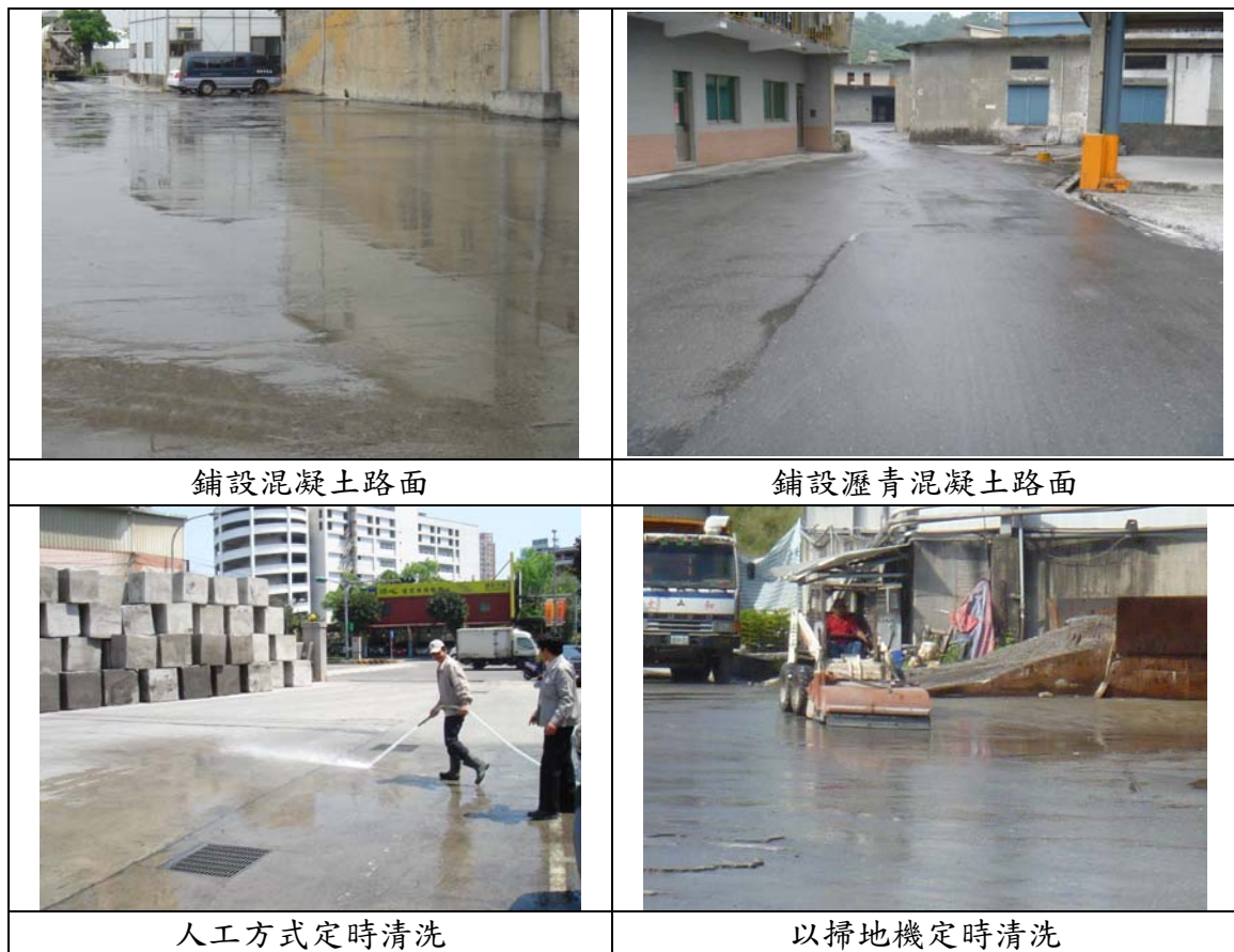
圖3-16 鋪設混凝土及瀝青混凝土實照
