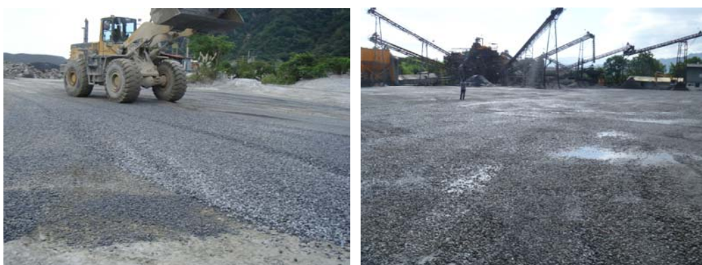
圖3-15 鋪設粗級配實照
