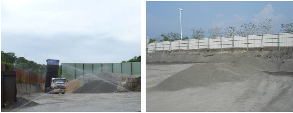
圖3-3 設置鐵皮擋風屏實照
