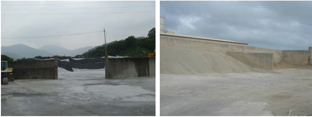
圖3-2 設置混凝土擋風牆實照
