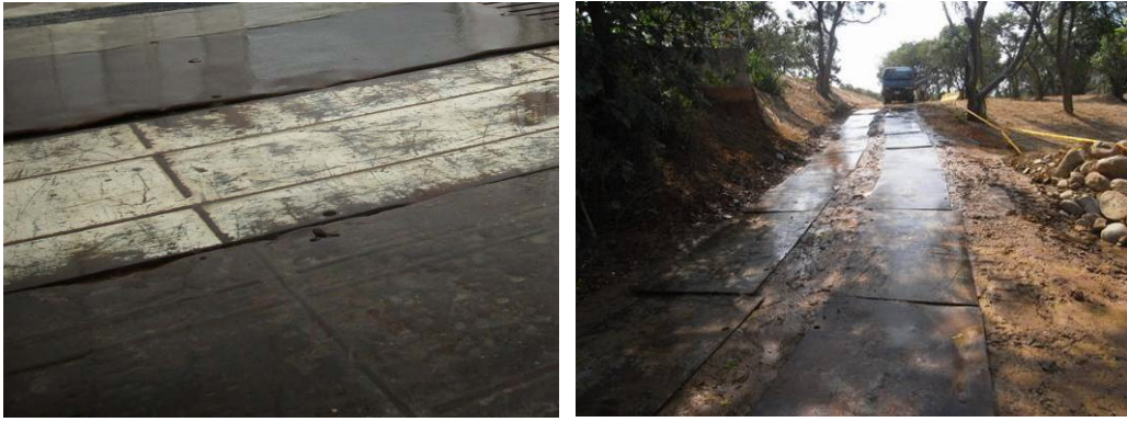
圖3-7 鋪設鋼板實照
