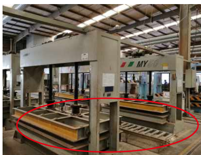
❌ 铺装废气未收集
