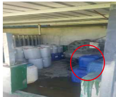
❌ 废料间未密闭,无废气收集处理设施
