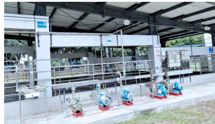
✅ 液态VOCs物料埋罐
