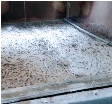
❌ 未充填活性炭, 废气直排 (违法)
