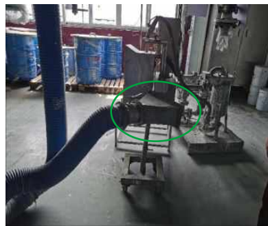
✅ 人工手动包装,安装废气收集设备
