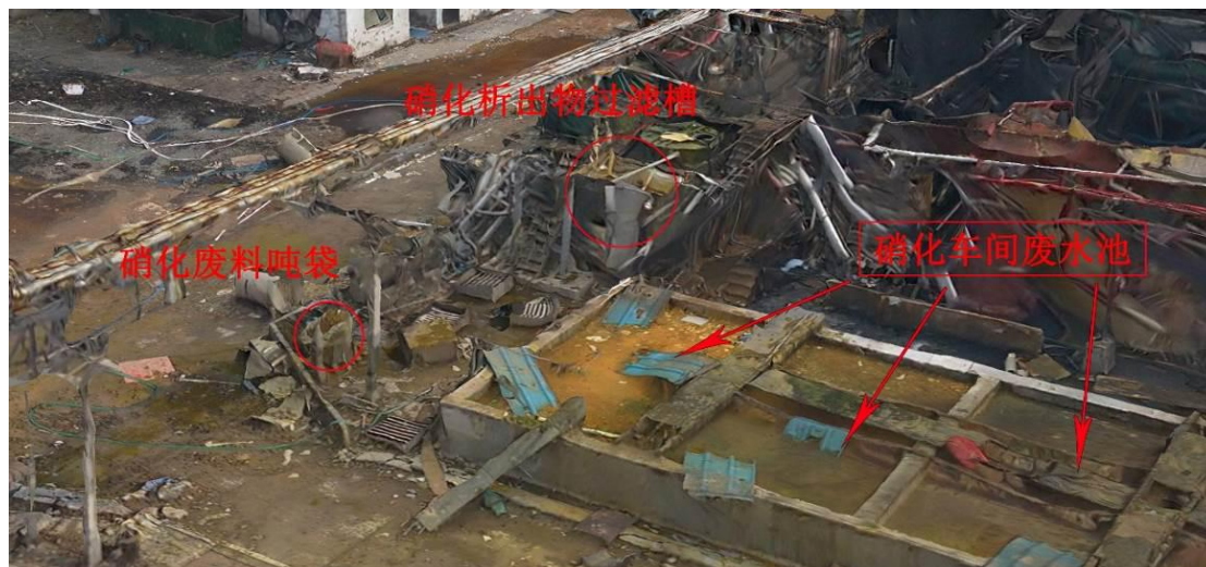
图3 硝化车间废水处理设施
