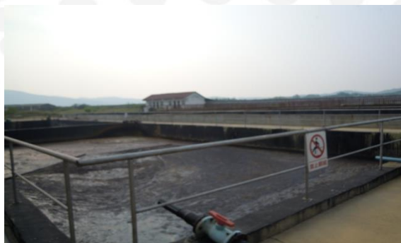
污水处理系统无组织排放
