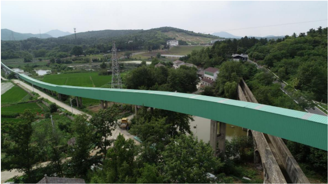
封闭式皮带运输廊
